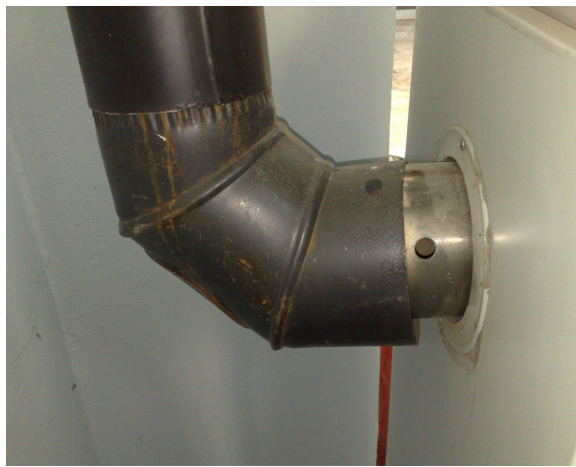
Мерно место на димном каналу котла, типа “B23”, произвођача “GENERATORE D’ARIA LALDA”
